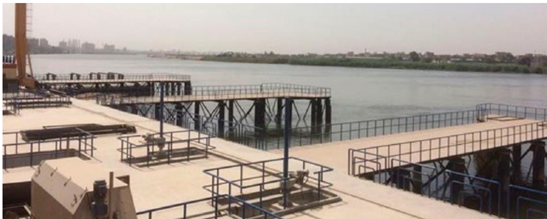
Captación New Cairo
