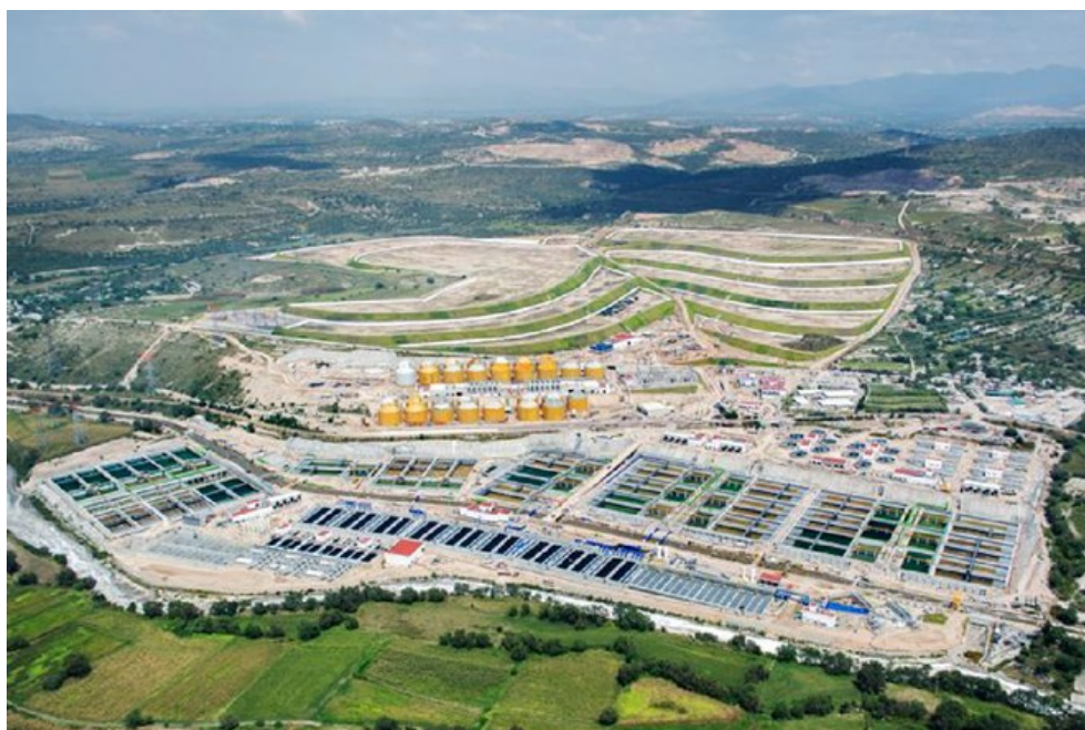
Depuradora de Atotonilco
